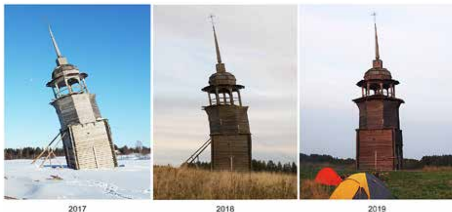
Рис. 4. Работы по выправлению колокольни в деревне Нименьга, проводившиеся в рамках проекта «Общее дело». Сравнительное состояние в 2017, 2018 и 2019 гг. Фото автора
