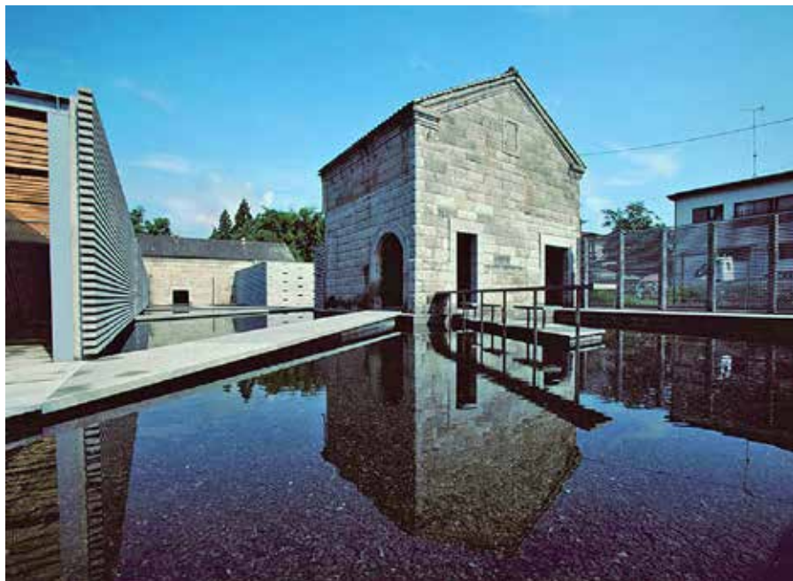
Рис. 5. Музей камня в Асино (архитектор К. Кума, 2000 г.). URL: https://www.world-architects.com/en/kengo-kuma-and-associates-tokyo/project/stone-museum
